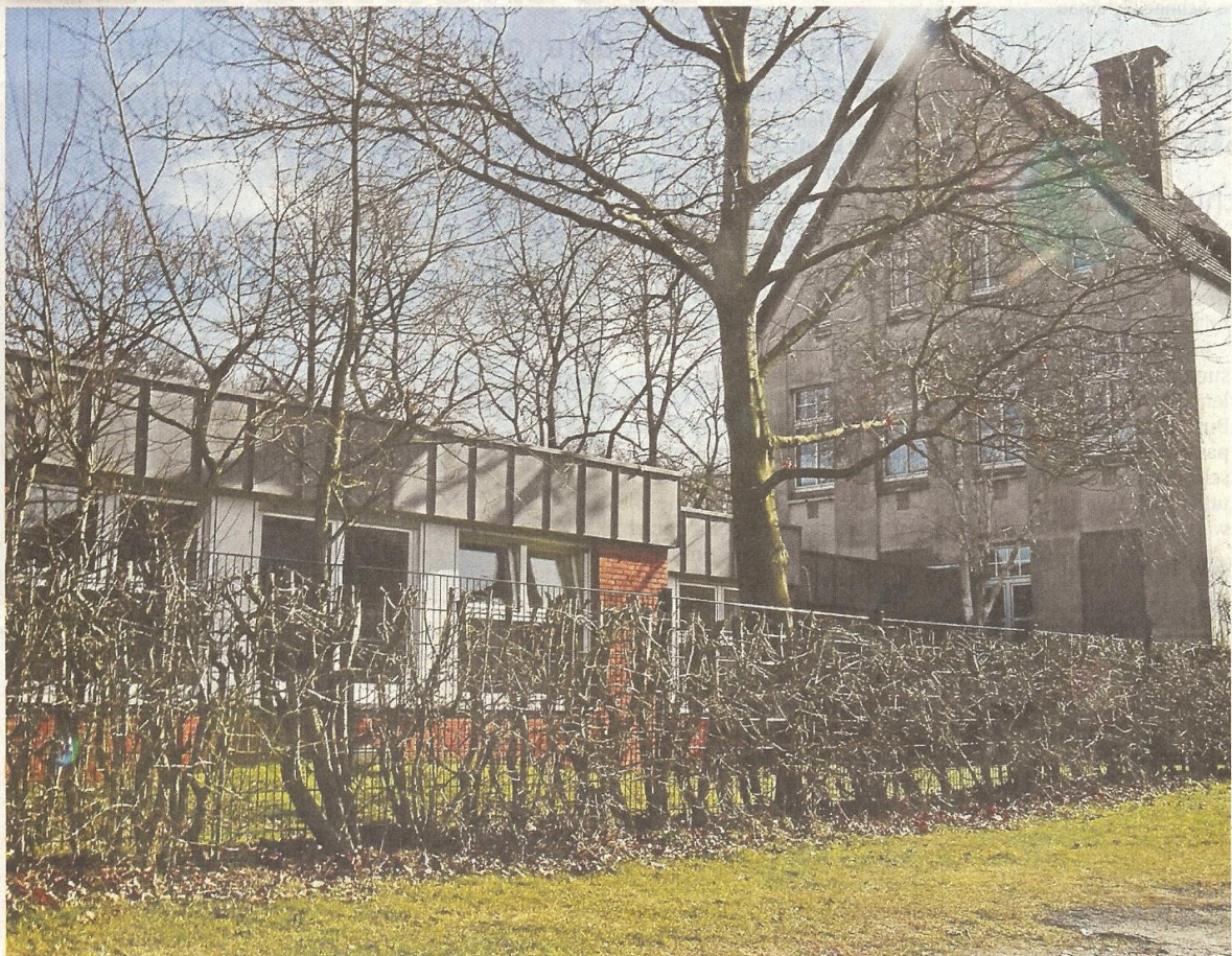
Die Kindertageseinrichtung (l.) wird erweitert. Das ehemalige Schulgebäude muss dafür weichen.
